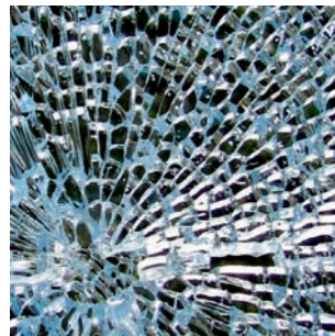
Rotura de Vidrio Templado
