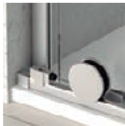
Detalle rodamiento y tope de freno
