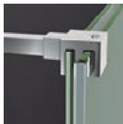
Detalle sujeción de barra superior
