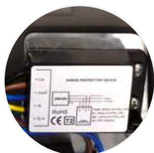
Protector de sobretensiones 20 kV
