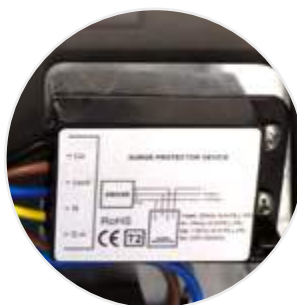
Protector de sobretensiones 20 kV
