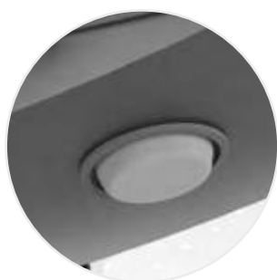
Sensor de movimiento por infrarrojos
