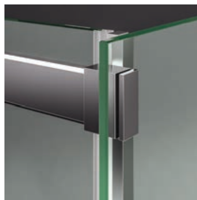
Detalle soporte lateral
